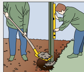
Ersten Pfosten einbetonieren (Kies-Sand-Zement-Gemisch; Betongüte C16/20 erdfeucht). Auf lotgenaues Ausrichten achten. Die Zaunelemente werden immer waagrecht verbaut. Wichtig: die Pfosten müssen ca. 2 cm höher als die oberste Motivplatte stehen!
